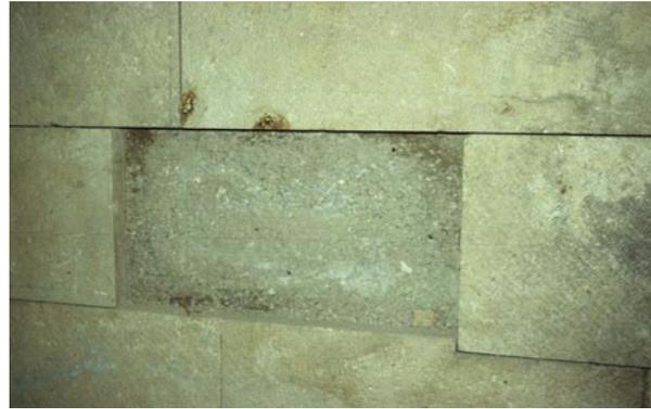
Abb.14: Ausschnitt aus Abb. 13. An dieser Stelle ist eine Platte der Wandverkleidung herausgefallen und gibt den Blick frei auf die Betonwand dahinter. Foto 1996.
